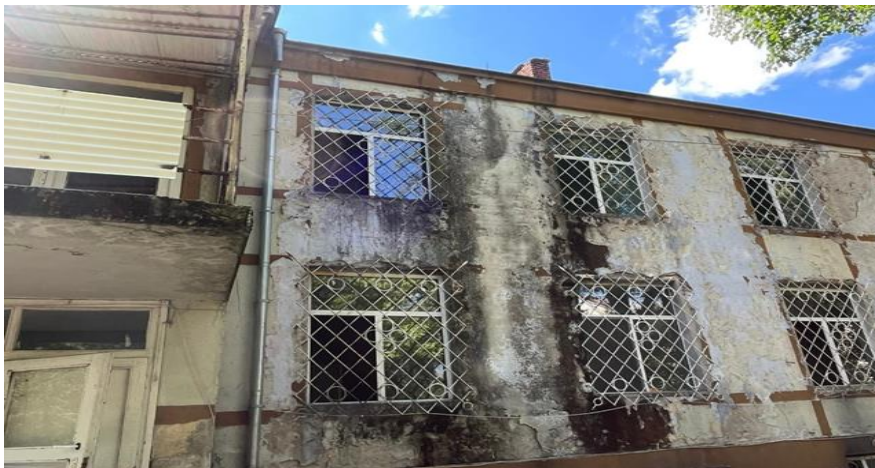
Фасадата на ДПБ - Раднево
